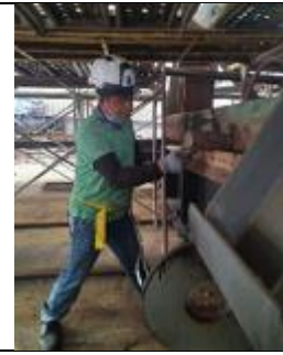
▲鐵工鋼板整順，需輔以大槌敲打亟需體力
